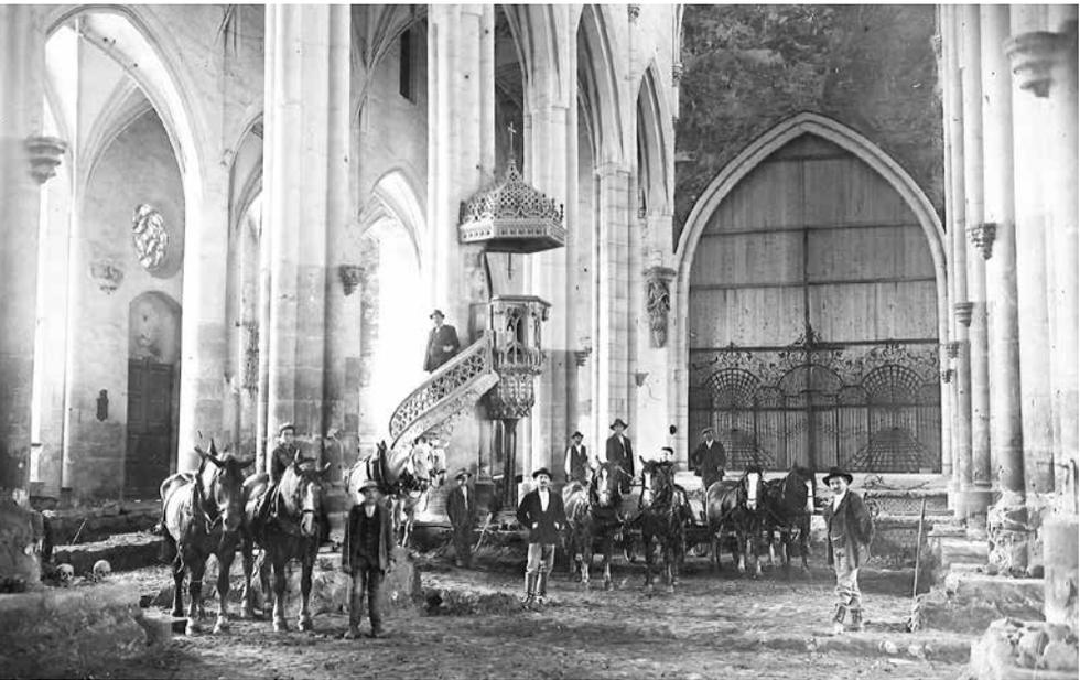
1912 wurden die Fundamente des Münsters für die Beseitigung von Wasserschäden freigelegt. Der frisch gerichtete Chor wurde mit einem Bretterverschlag geschützt.
